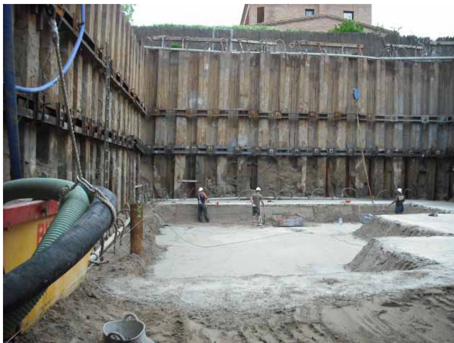
EL SISTEMA TABLESTACAT ÉS UNA PANTALLA HERMÈTICA DE PLANXES D'ACER CLAVADES A TERRA
