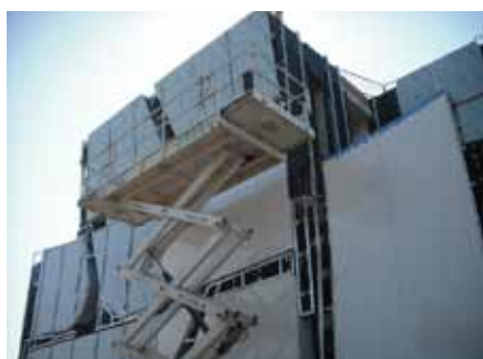
L'EDIFICI QUEDA ABSOLUTAMENT EMBOLCALLAT, TOTA LA PELL ÉS D'ALUMINI I VIDRE
