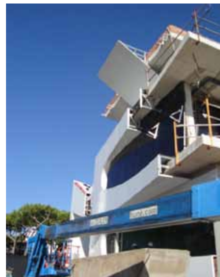
UN COP DIBUIXADA I DEFINIDA AMB TOT DETALL LA PELL EXTERIOR, ES DISSENYEN DIFERENTS SISTEMES D'ANCORATGE PER A CADA ZONA DE LA CASA
