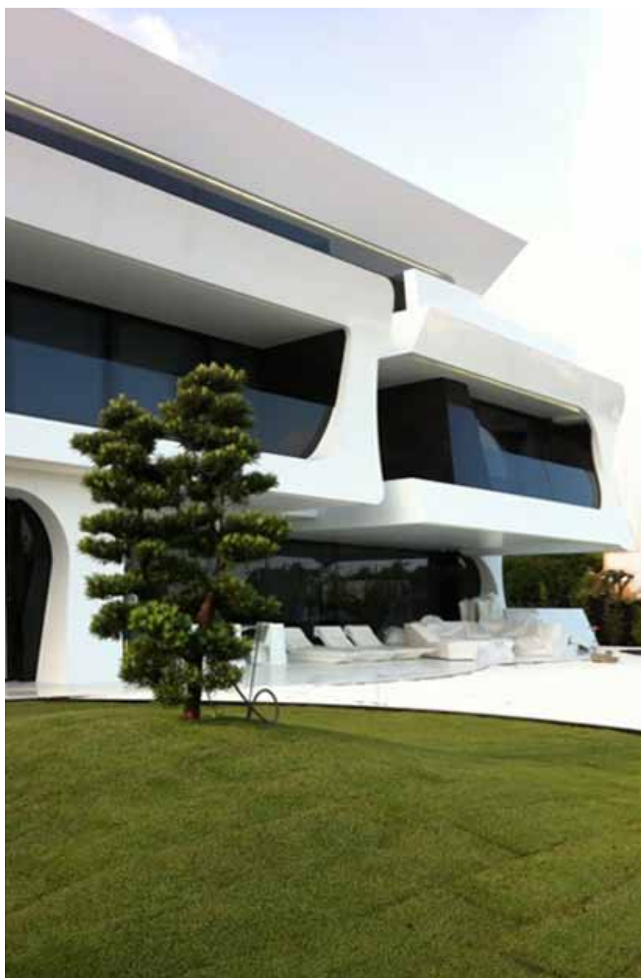
LA FUSTERIA EXTERIOR ÉS DE PERFILERIA OCULTA, AMB FORMES I DIMENSIONS ESPECIALS, INCLINADES, CORBADES, DESPLOMADES
