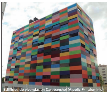
Edificios de viviendas en Carabanchel (Alpolic Fr - aluminio)
